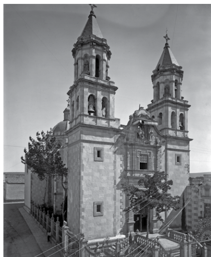
Iglesia de la Congregación de Guadalupe, fachada. SINAFO.
