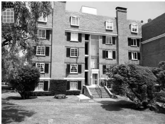
Fachada de edificio del Conjunto Residencial Pedregal 2 .
