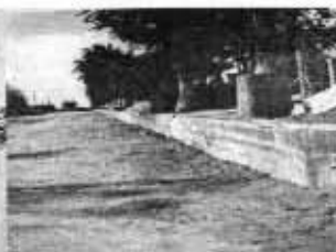
Guarniciones previas a la pavimentación.
