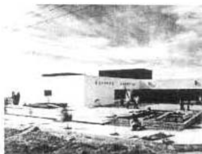
Edificio de la clínica del Seguro Social.
