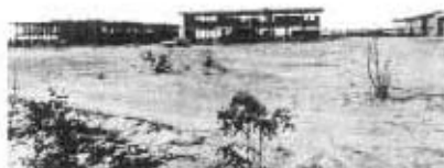
Construcción de la Unidad Militar.
