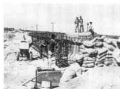
Puente Las Bramonas.
