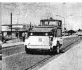
El pavimento requirió adquirir una barredora.
