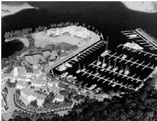
Figura 5. No delimitación de la zona federal marítimo terrestre (marinas).
