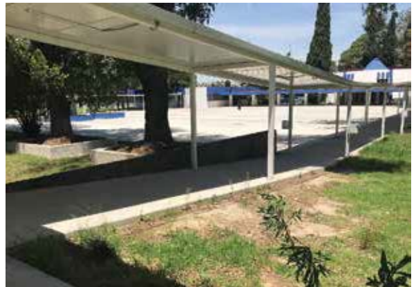
Rampas de acceso en el Hospital Psiquiátrico "Dr. Rafael Serrano", Puebla.
