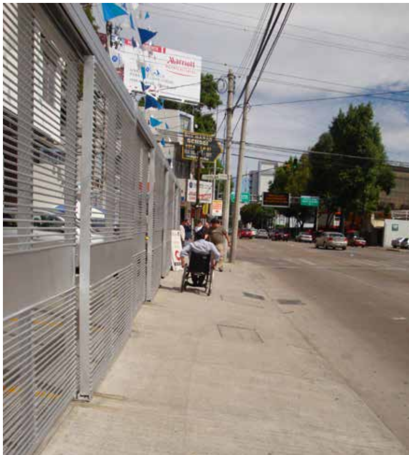
Foto 2. Banqueta nueva con pendiente de 12% lateral en Patriotismo, esquina con Holbein, Mixcoac, Distrito Federal
