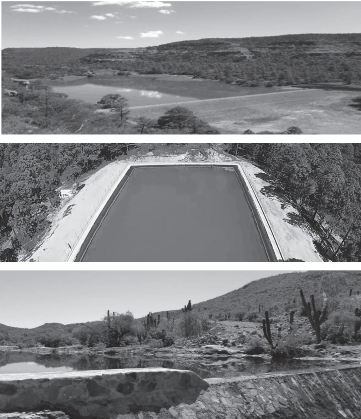
FIGURA 6 OLLA DE AGUA, ALJIBE Y PEQUEÑA PRESA
