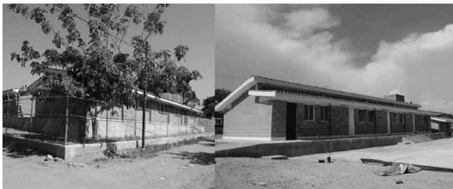
Construcciones recientes por daños de los huracanes del ciclo de lluvias del 2013.
